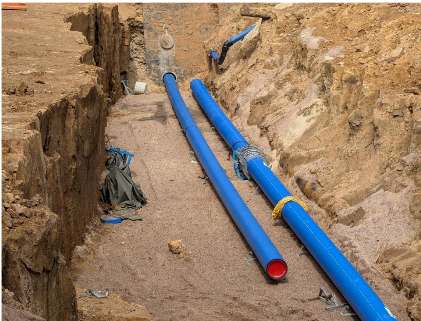
Foto: Neue Wasserleitungen für Barsinghausen // Stadtwerke Barsinghausen GmbH
